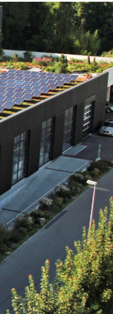
Dachgartenlandschaft Firmengebäude Contec AG, Uetendorf BE, kurz nach der Fertigstellung. Begrünte und unbegrünte Photovoltaik-Module, Pavillon, Erholungsflächen.
