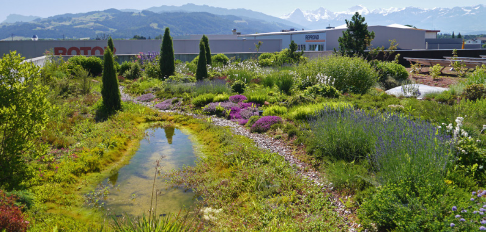
Paradiesische Dachgartenlandschaft mit Feuchtbiotop. Im Hintergrund rechts PV-Module aufgeständert.
