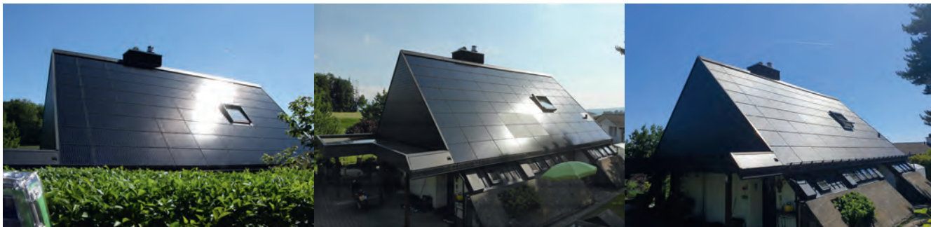
Bild 4 Das Norddach des betroffenen Einfamilienhauses vor der Blendsanierung (links), bei der Bemusterung (Mitte) und mit den neuen satinierten PV-Modulen (rechts).
